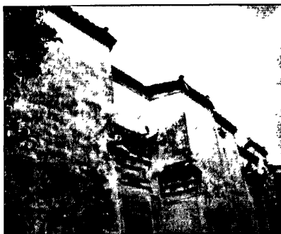
图 2-13 皖南民居正面 图片来源：实拍
