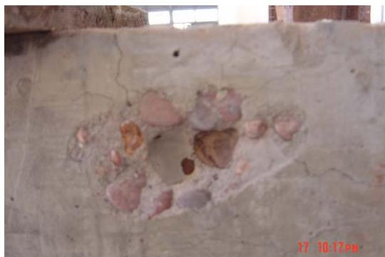
图 4-12 混凝土的爆裂
