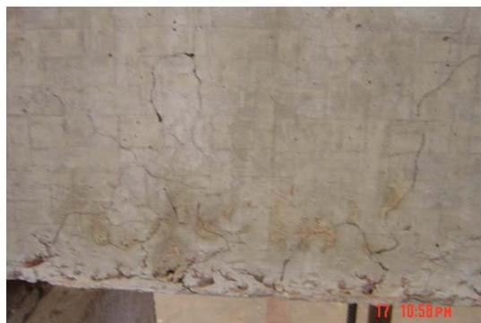
图 4-13 混凝土表面裂纹
