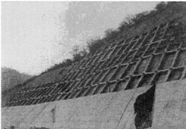
图 2.4 某预应力锚索框架结构实例
